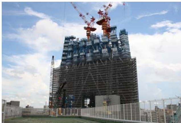
東京スカイツリー工事状況
