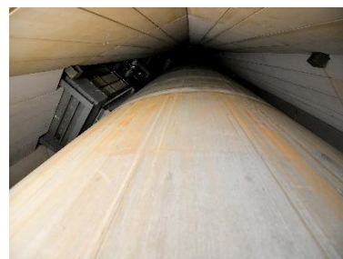
△東京スカイツリー内部の構造物 「心柱」
