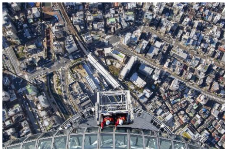
△天望回廊の窓ガラス清掃を上から見た様子
