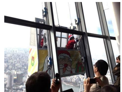
△東京スカイツリー展望台窓ガラス清掃 (過去の様子) ©TOKYO-SKYTREE
